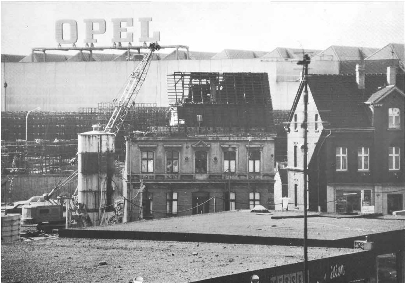
Abriss der alten Einkaufsstraße, im Hintergrund der Bau des Opelwerks, im Vordergrund provisorische Einkaufs-Pavillons
