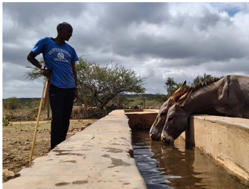
Dank solarbetriebener Pumpen können Massai-Gemeinden wie die von Olorium ihr Vieh zuverlässig tränken.
